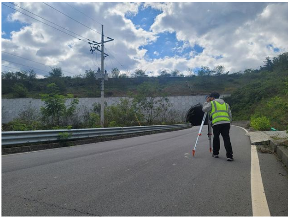
광파기를 이용한 측량 작업사진
